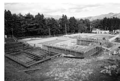
老朽化した第1浄水場の改修工事
